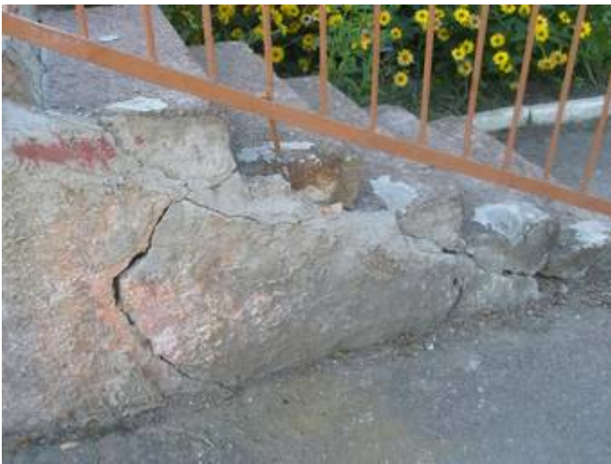
Die Treppen vorher ...
