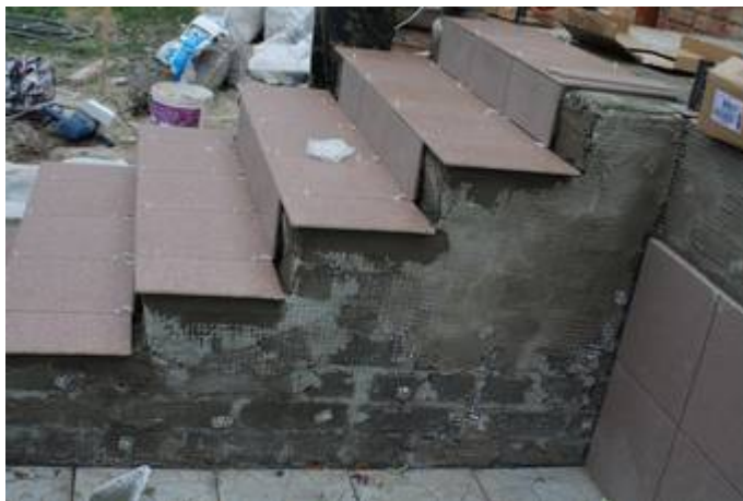
... und die Treppen nachher (hier gehen die Arbeiten allerdings noch weiter)
