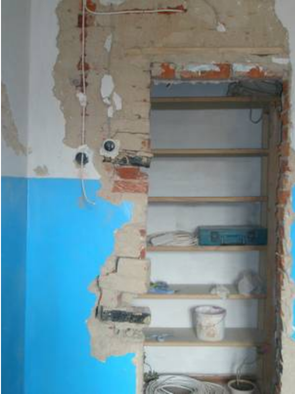
Schulraum Blick vom Fenster vorher
